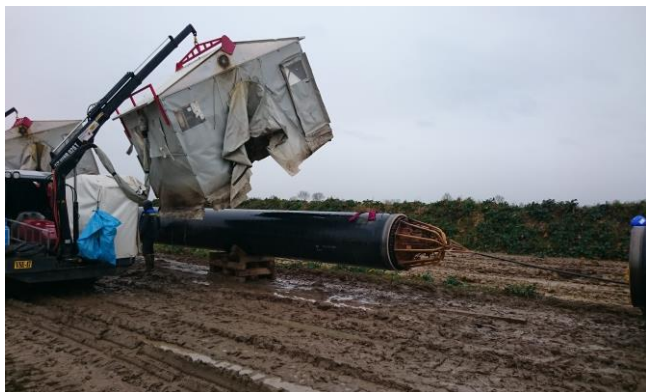
Wycieczka przedmiotowa – budowa gazociągu.
